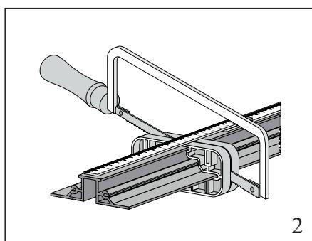
2. С помощью направляющей и ножовки укоротите лоток до необходимых размеров.
